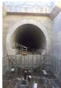
西谷トンネルの 羽沢方坑口
